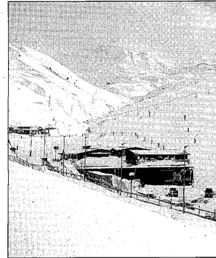
Aspecto que presenta Astún. S.E.
